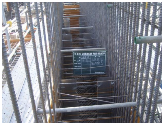
収縮低減目地設置完了
