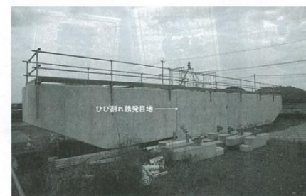
隣接する工区で別の建設会社が施工した橋脚。こちらは梁などひび割れ誘発目地を設けている
