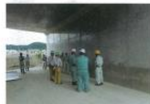
ボックスカルバート側壁下部にNDリターダーを加えたコンクリートを打設した(写真:日本コンクリート技術)
