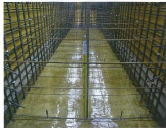
写真3 ■ NDRを打設する梁の断面の側面。型枠内には、余剰水の析出を防ぐ透水性シートを張った。(写真右も西海建設)
