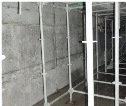
収縮低減目地設置完了
