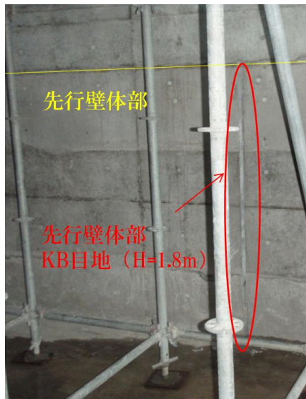
側壁部の先行壁体部の目地の状況
