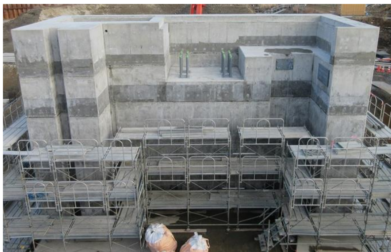
施工状況(全体)
