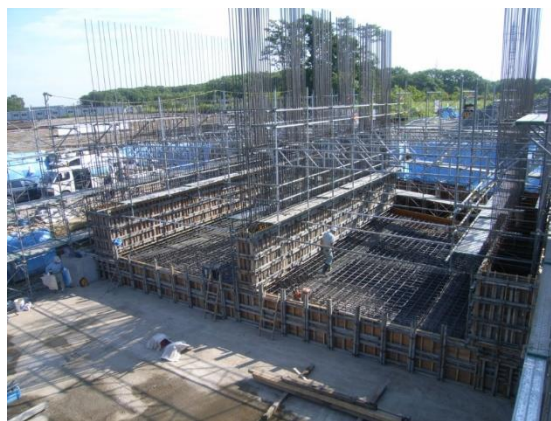
先行壁体部型枠組立完了
