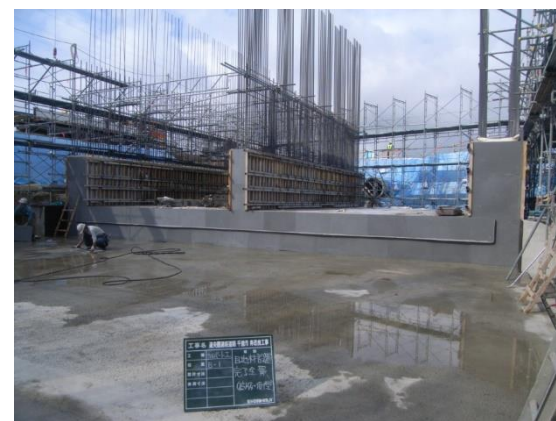
先行壁体部の型枠脱型状況
