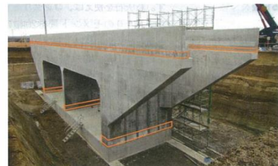
写真5 ■ 国土交通省北海道開発局が発注した工事でNDR(枠部分)を採用した例。図体の側壁だけでなく、高欄の下端にも使った。(写真:玉川川)
