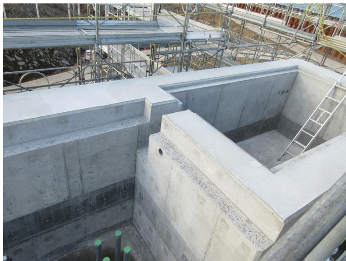
施工状況(豎壁)
