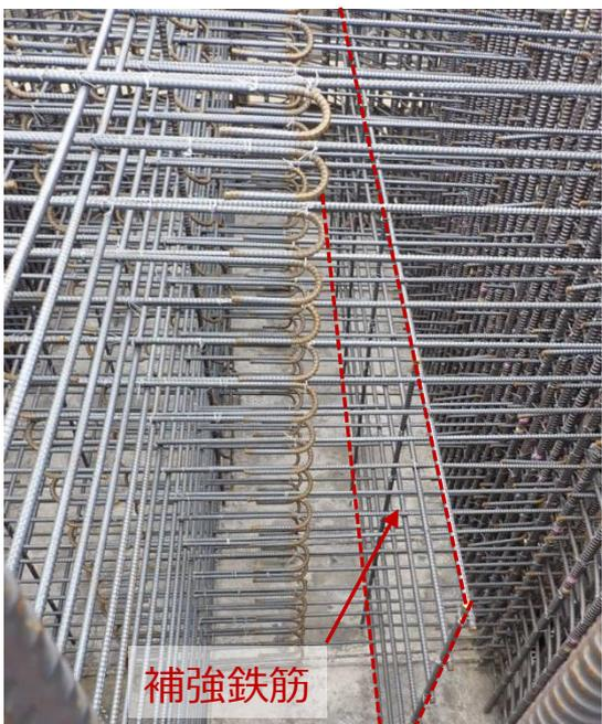
▼補強鉄筋の配置図
