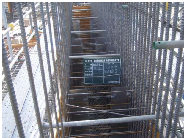
収縮低減目地設置完了
