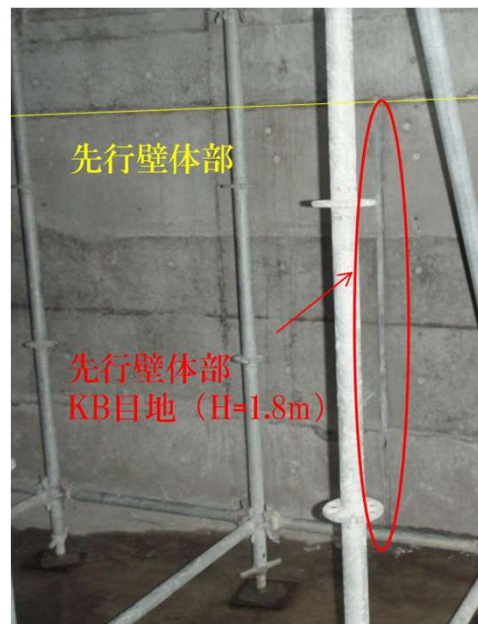
側壁部の先行壁体部の目地の状況
