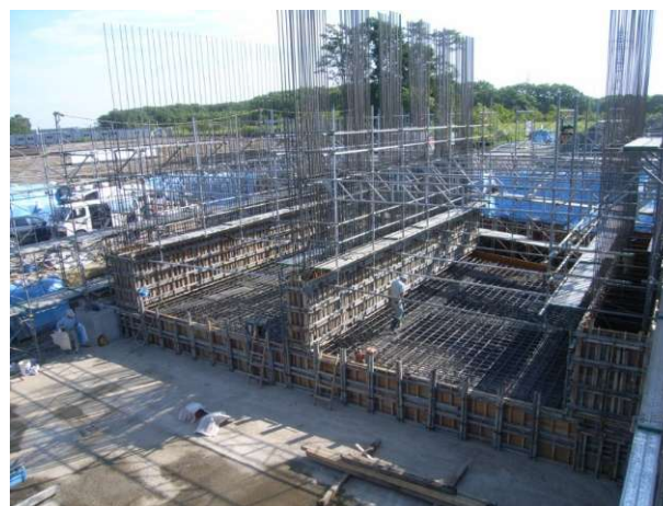
先行壁体部型枠組立完了
