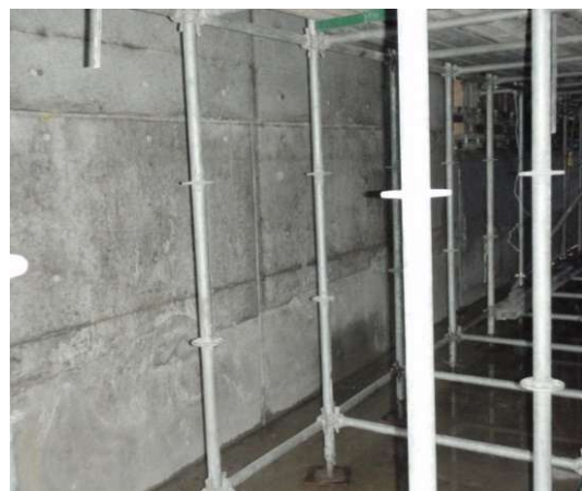
収縮低減目地設置完了
