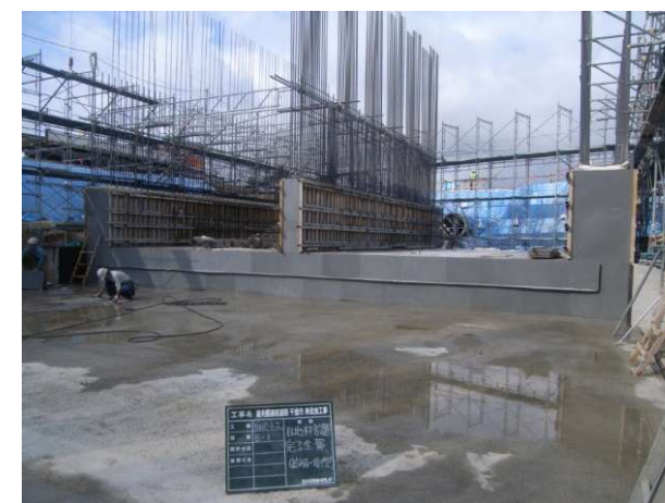
先行壁体部の型枠脱型状況
