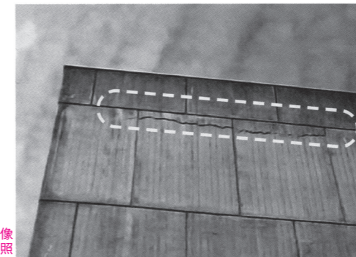
写真 西側の外壁面におけるひび割れ発生状況
