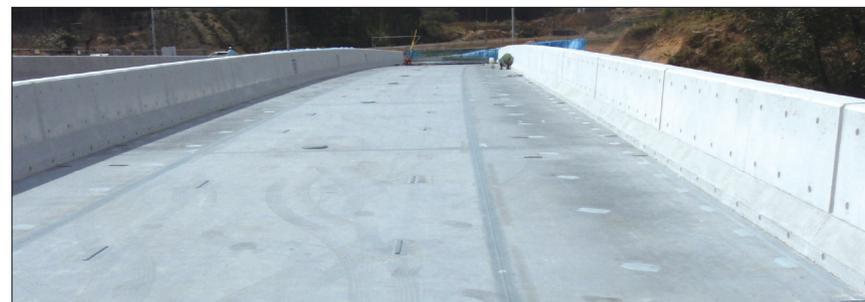
橋梁上部工の構造 (RC床版および壁高欄)
