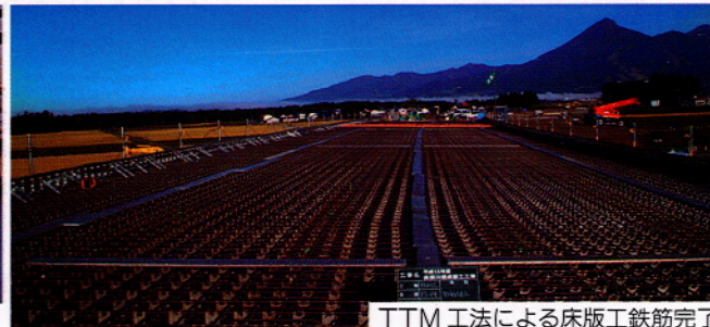
TTM工法による床版工鉄筋完了
