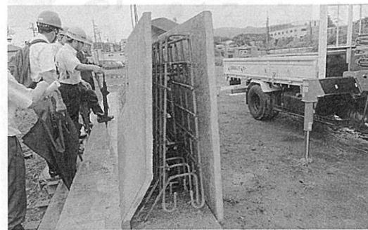
ユニット型枠システムの配筋状況
