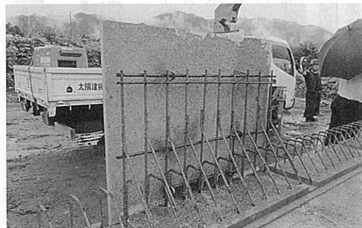
外周SDP方式の配筋状況
