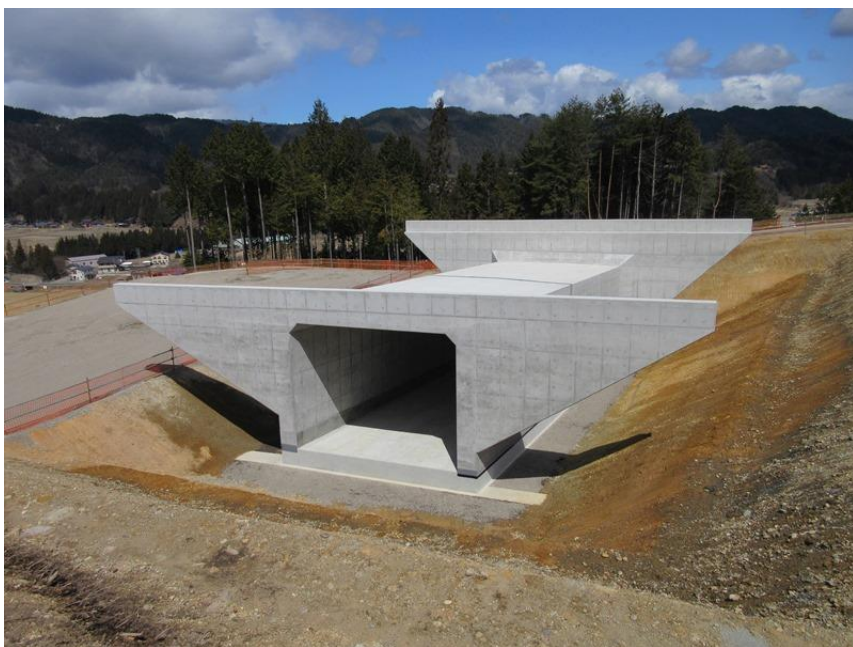
完成写真(正面方向)
