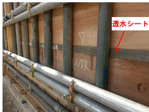
写真-2 透水シートからの排水状況
