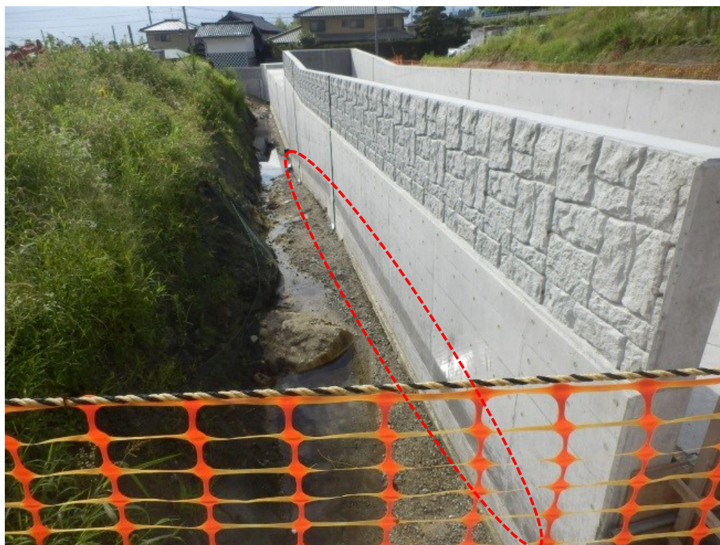
写真-3 完成したU型擁壁の外観（外側）
