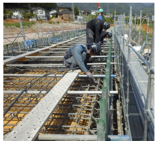
写真-1 コンクリート打設状況
