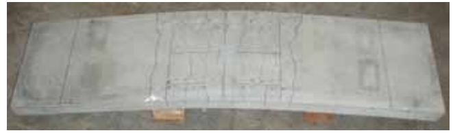
写真-7 ひび割れの分散状況
