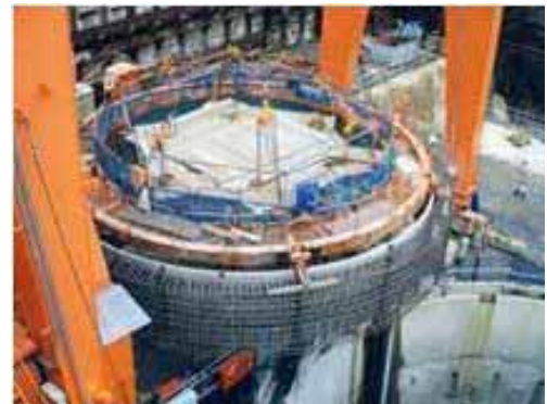
(c) 原子力発電所の放水路縦坑
