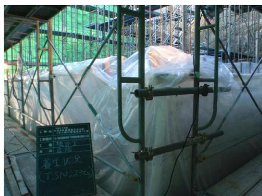
写真-3 養生システム適用状況
