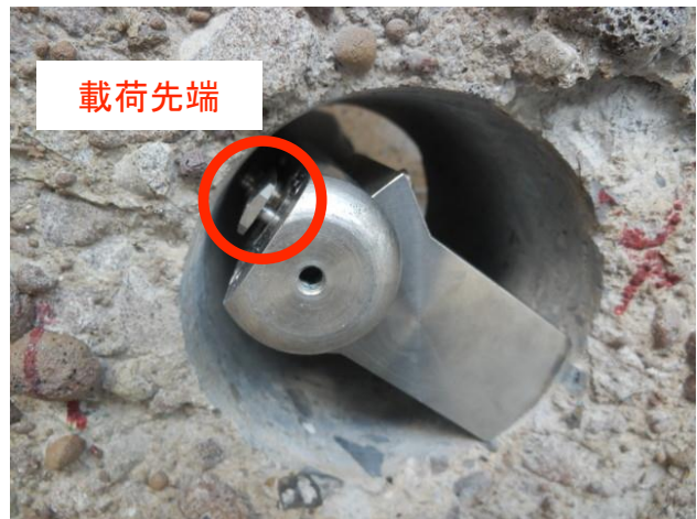
写真-1 孔内载荷試験装置
