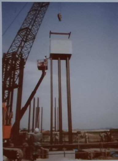
函体建込状況
