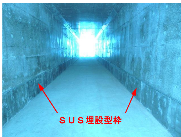
写真-12 函渠工の内面
