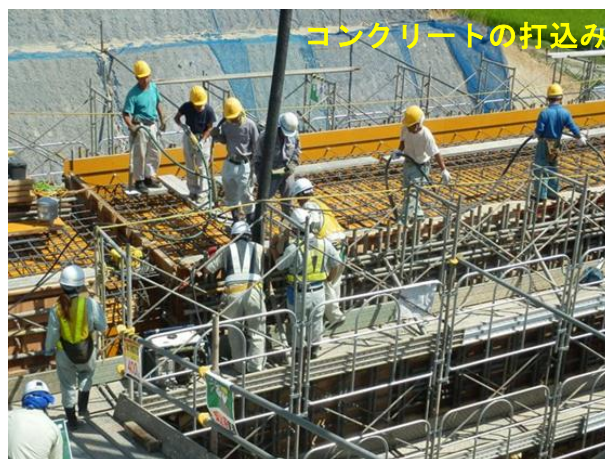
写真-10 函渠工の施工状況
