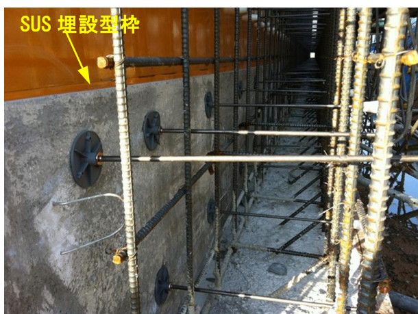
写真-9 SUS埋設型枠の組立状況
