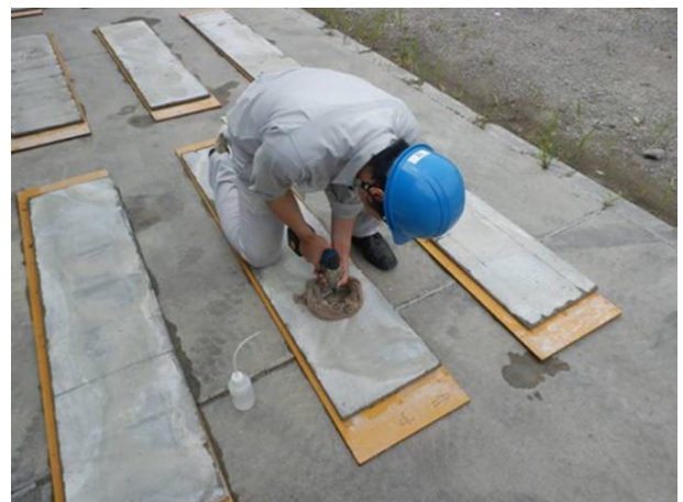
写真-8 SUS埋設型枠の孔あけ加工状況
