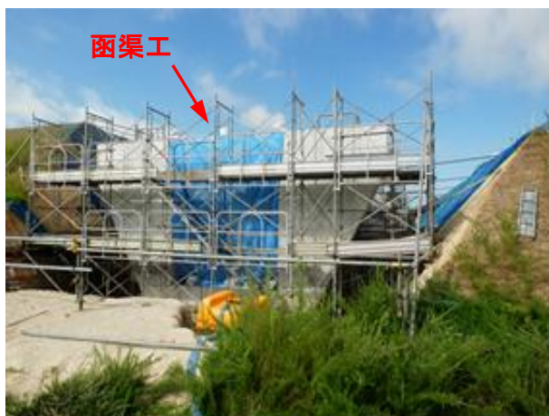
写真-11 函渠工の外観
