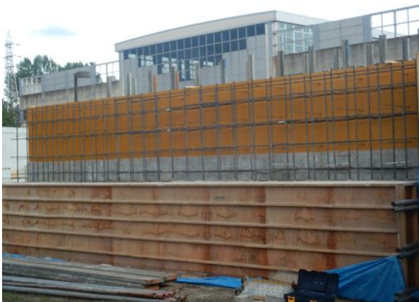
写真-7 SUS埋設型枠の組立状況
