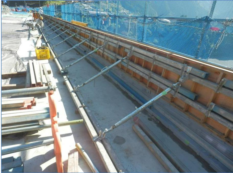
合板型枠(内側)のサポート設置状況
