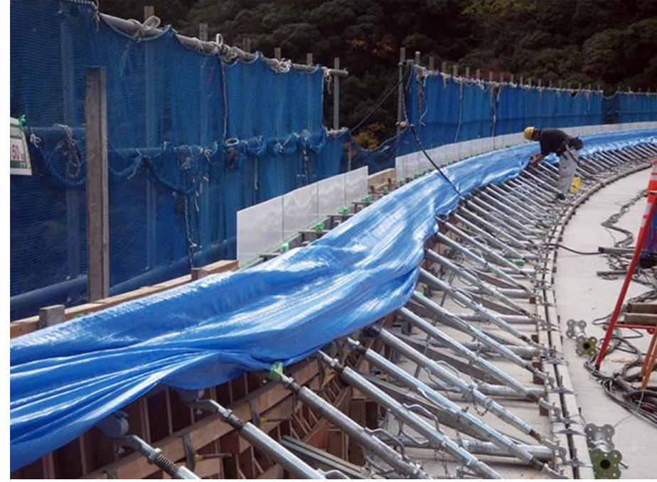
合板型枠の組立状況(曲線区間)
