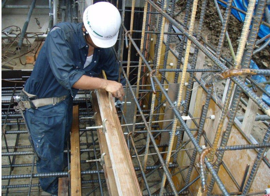
先行壁体の施工方法
