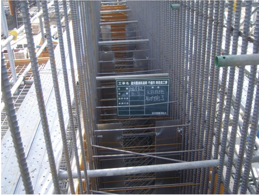
KB目地設置完了 (先行壁体部)
