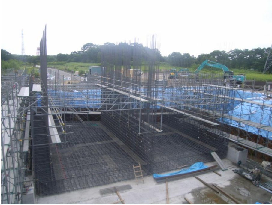
先行壁体部鉄筋組立完了
