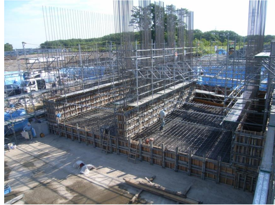
先行壁体部型枠組立完了
