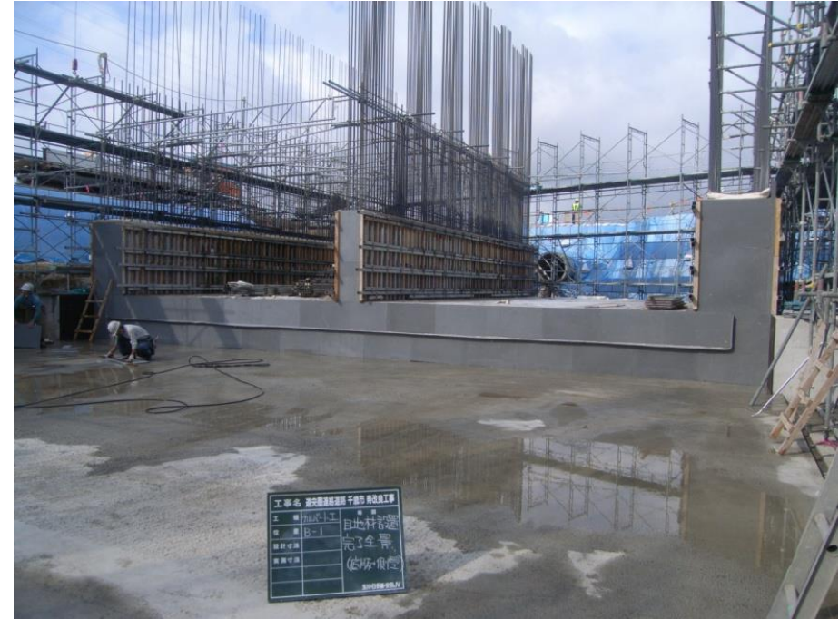
先行壁体部の型枠脱型状況
