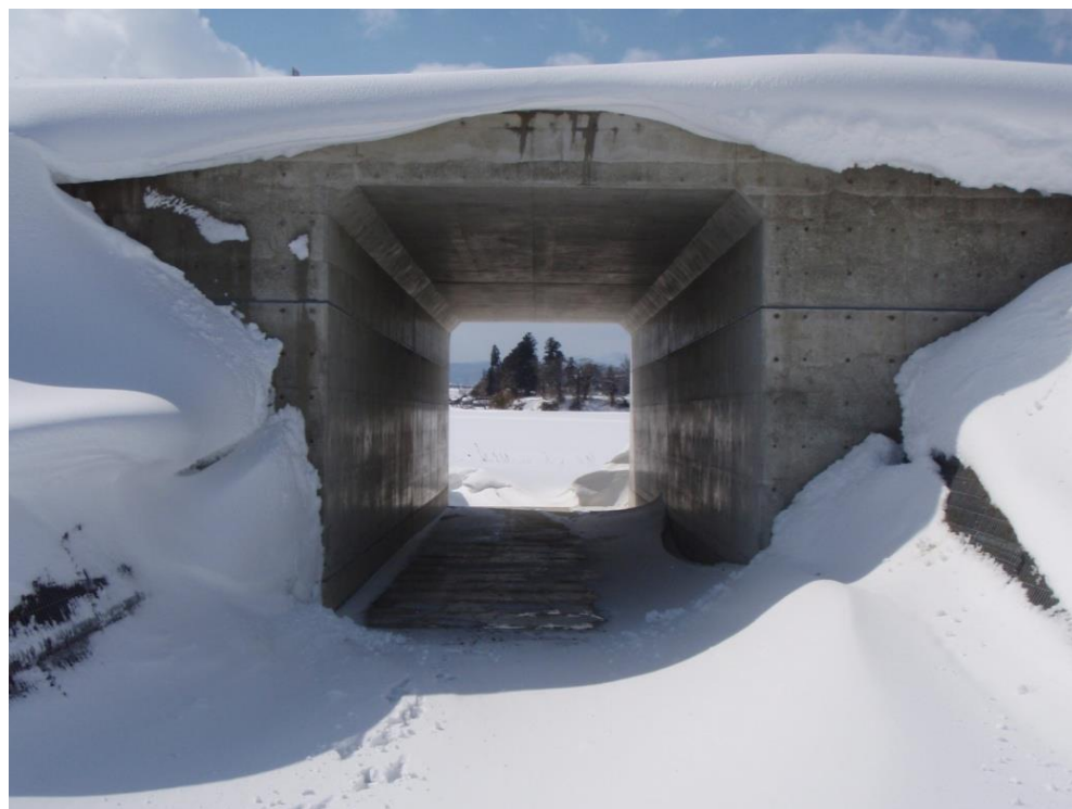
完成後の状況
