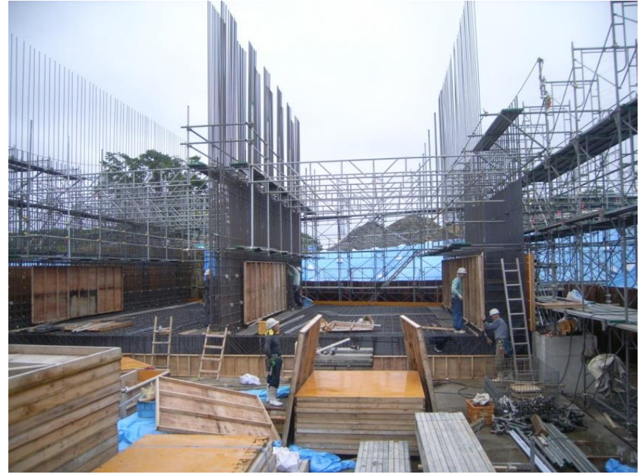
先行壁体部型枠組立状況
