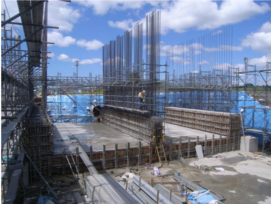
コンクリート養生状況 (底版および先行壁体)
