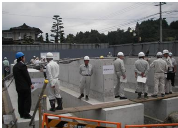
大型実証試験体による検証
