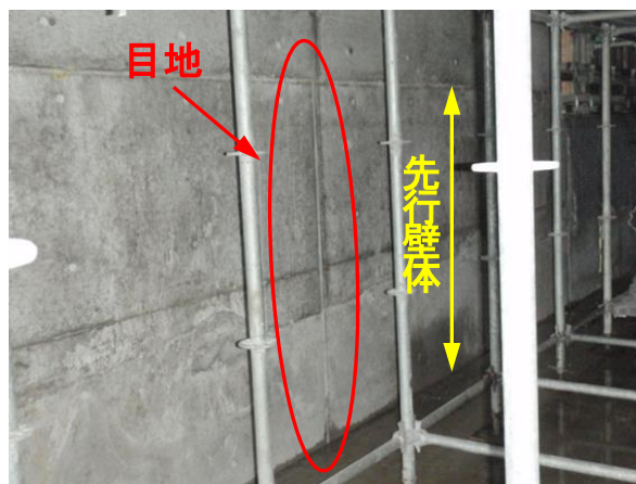
先行壁体部の仕上がり
