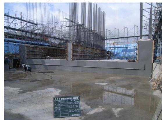
▼側壁部の先行壁体部の収縮低減目地の状況
