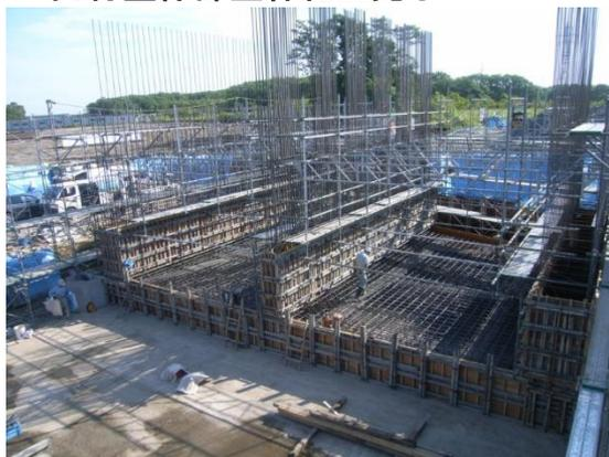
▼先行壁体部の型枠脱型状況
