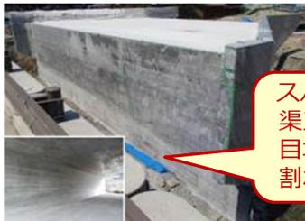
スパン32mの函渠工に対し誘発目地なしでひび割れ防止を実現
