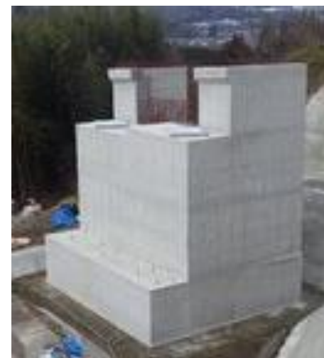
長野県発注 令和4年度防災・安全交付金(道路)工事
