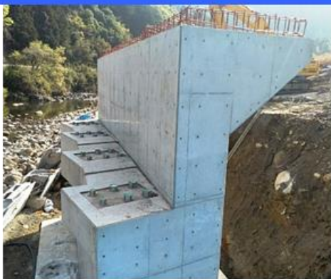
三重県発注 一般国道368号(上長瀬)道路改良(2号線下部工)工事
