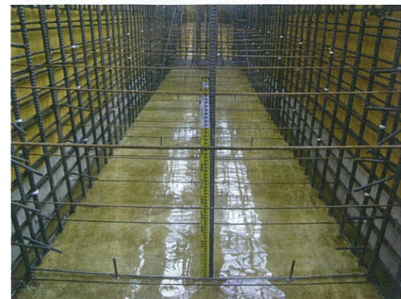
写真3 ■ NDRを打設する梁底部の側面の型枠には、余剰水の排水を促す透水性シートを張った(写真:右も西海建設)
