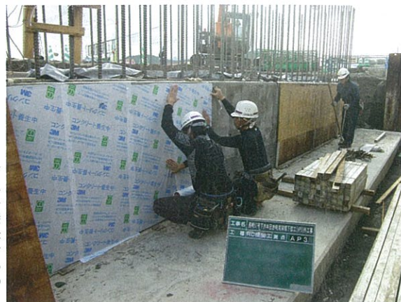
写真4 ■ 柱部のコンクリートは、脱型直後も水分の蒸発を防ぐシートを張って2週間以上養生した。NDRを打設した部分は色がやや濃くなるものの、埋め戻される範囲なので美観上の問題はない
