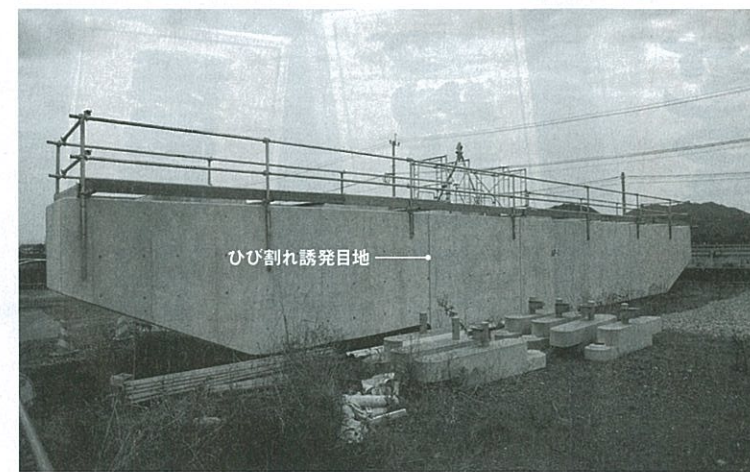
隣接する工区で別の建設会社が施工した橋脚。こちらは梁などにひび割れ誘発目地を設けている
