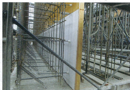
型枠の表面には透水シートを張り付けて、ブリーディングによる美観低下を防ぐ(写真:井口建設工業)
