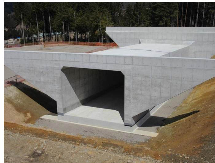
函渠工外観(全景)
