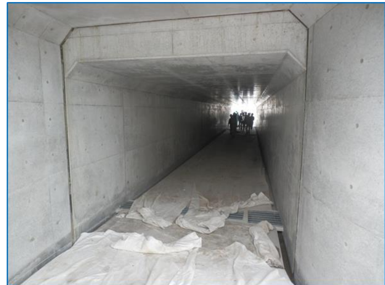
完成写真(函渠工)
