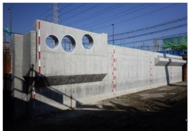
NO.49交防広河第4号河川改修工事
