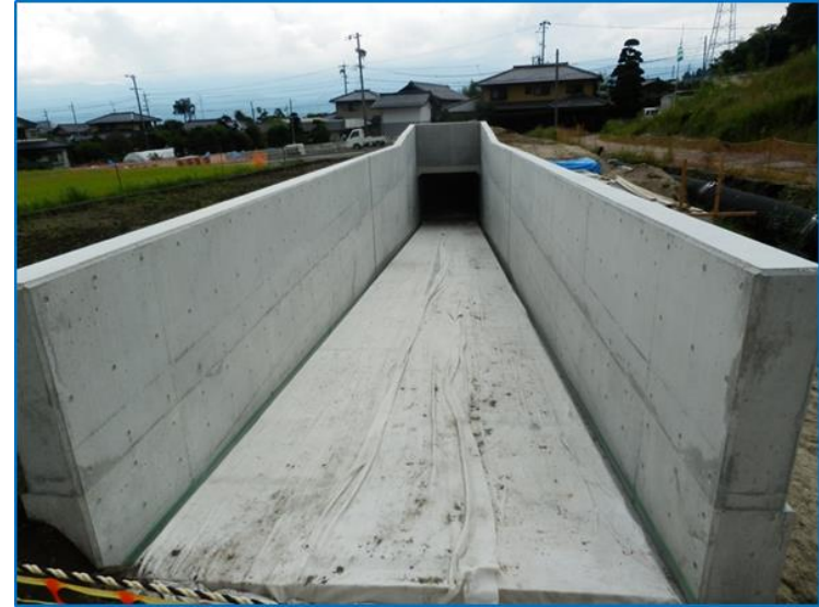
完成写真(U型擁壁)
