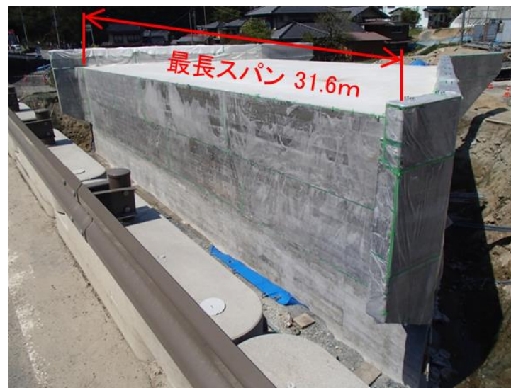
完成写真(左岸上流より)
