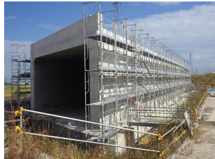
完成写真(側面)
