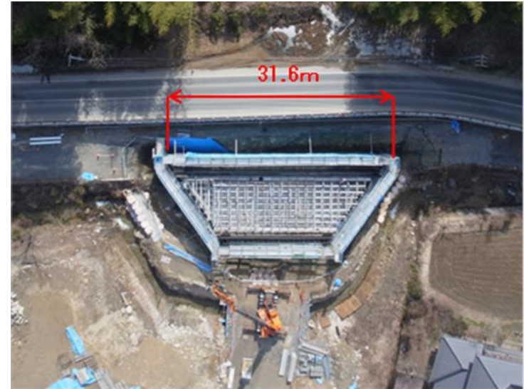
全体構造(施工時に上空から撮影)
