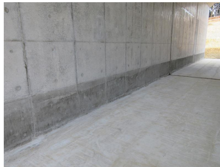
函渠工内空 (NDリターダー添加部分)
