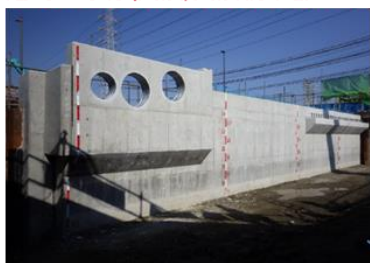
NO.49交防広河第4号河川改修工事
