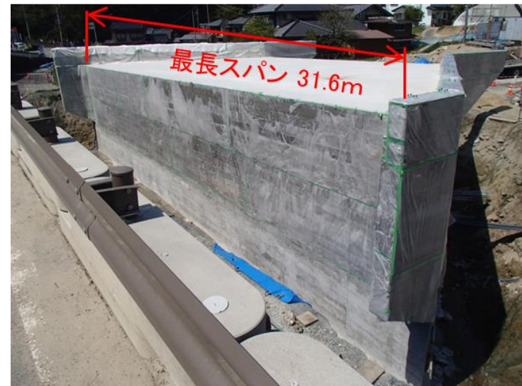
完成写真(左岸上流より)
