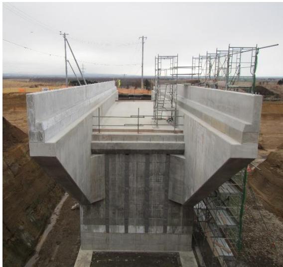
壁高欄の施工にも適用
