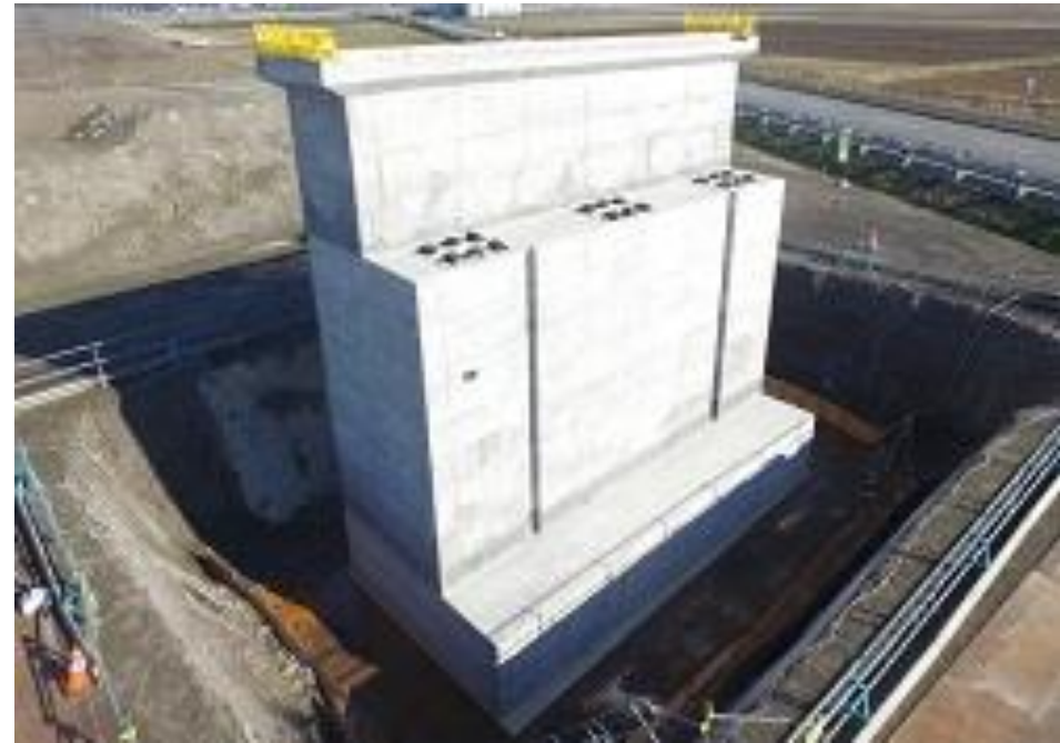
橋梁下部工・橋台 (国土交通省東北地整発注)
